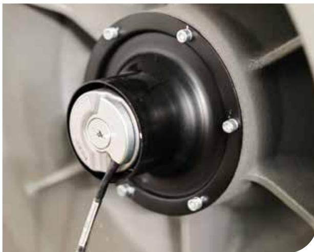
Imagem do Encoder instalado no motor.
