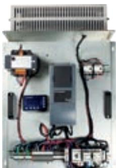
Inversor de potência instalado dentro do poço do elevador.
